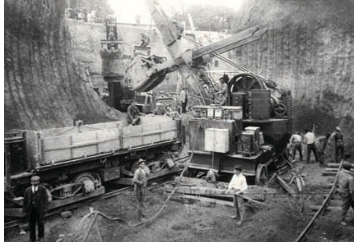
Fotografía no identificado Construcción del subte Línea A, 1912. AGN
